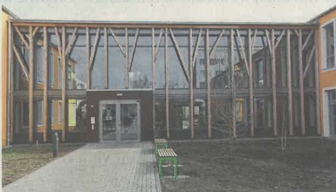
Die Außenanlagen der Kita sollen bis zum Mai mit Fußballplätzen, Terrassen, Sandkästen, Klettergerüsten und Grünanlagen fertiggestellt werden.
